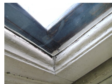
Figura 8.1 - Particolare serramenti da sostituire.
