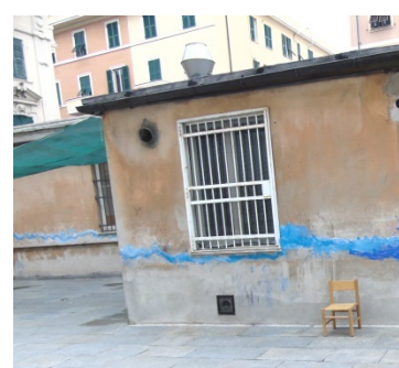
Figura 8.3 – Particolare della facciata da isolare esposta a nord
