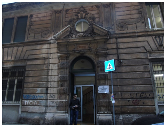
Figura 1.1 - Vista della facciata Sud (ingresso)
