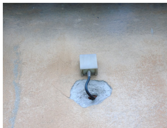
Figura 4.8 – Sonda climatica esterna
